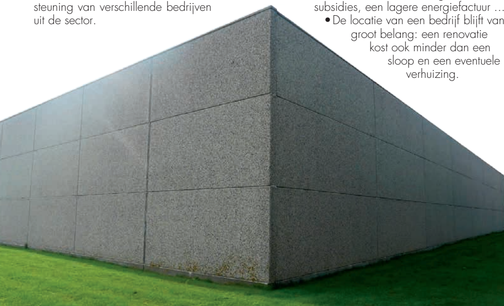
De bekende architectuur van tal van industriële panden: 100% functioneel, maar zonder al te veel aandacht op de look en de energiehuishouding van het pand
