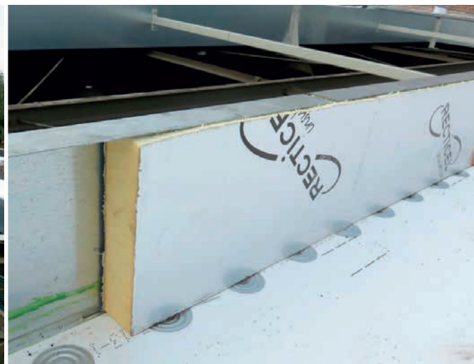
Vanwege de uitzettingscoëfficiënt wordt eerst de horizontale isolatie geplaatst met daarop dan het TPO. Dan pas wordt de verticale isolatie geplaatst tegen de opstanden
