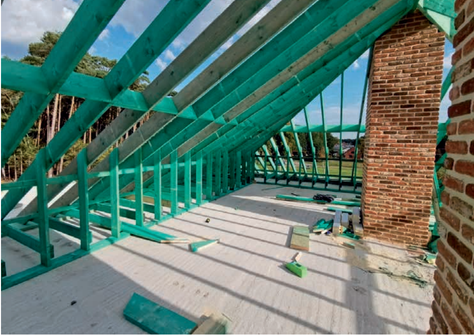
Zaakvoerder Umut Topal heeft het afleveren van kwaliteit erg hoog in het vaandel
