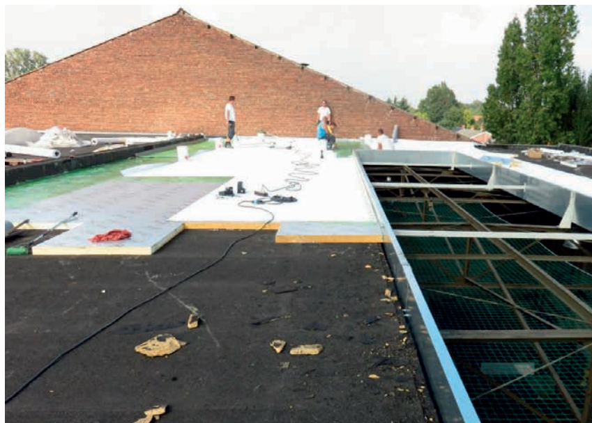
Bij de renovatie kan een intacte bitumenlaag nog dienen als dampscherm voor de isolatie die erop gelegd wordt
